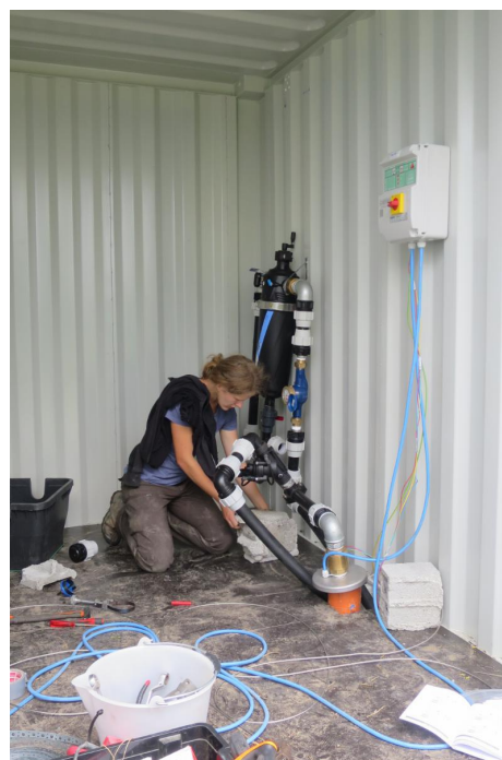
13 juin - Mise en place du circuit! 2ème étape Le défi consiste maintenant à faire passer le tuyau destiné à la purge de la pompe dans un tout petit trou de souris... et on sera bon pour le circuit principal! On aime les défis!
