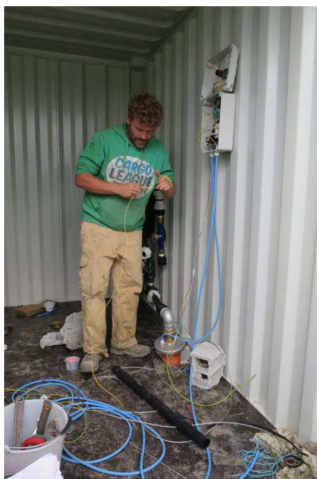
13 juin - Mise en place du circuit! 2ème étape Deuxième journée passée sur les branchements. On démarre par le raccordement des sondes de la pompe au boîtier.
