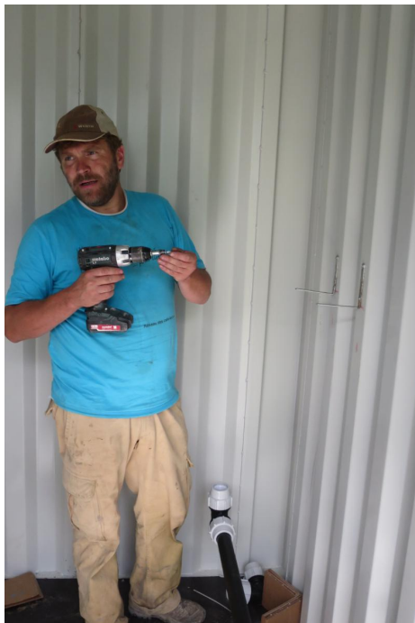
12 juin - Mise en place du circuit! 1ère étape C'est qui le roi de la perceuse!?? ahahah!! ( on ne précisera pas qu'il nous aura fallu bien plus de temps à percer le tuyau destiné à recevoir le manomètre, que le mur du conteneur! )
