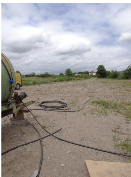
18 juin - Mise en place du circuit! 3ème étape Voilà, nous avons pu récupérer les embouts manquants, c'est partie pour la mise en place du réseau secondaire.
